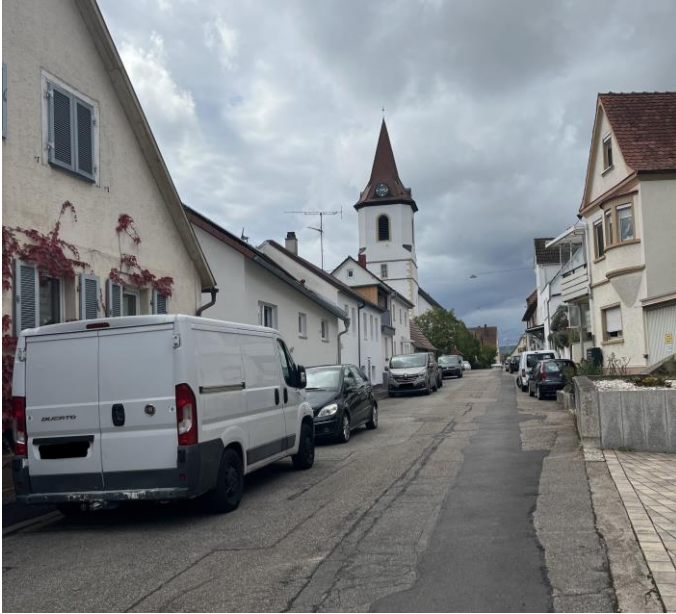
Abbildung: Gebäudebestand Kirchstraße
